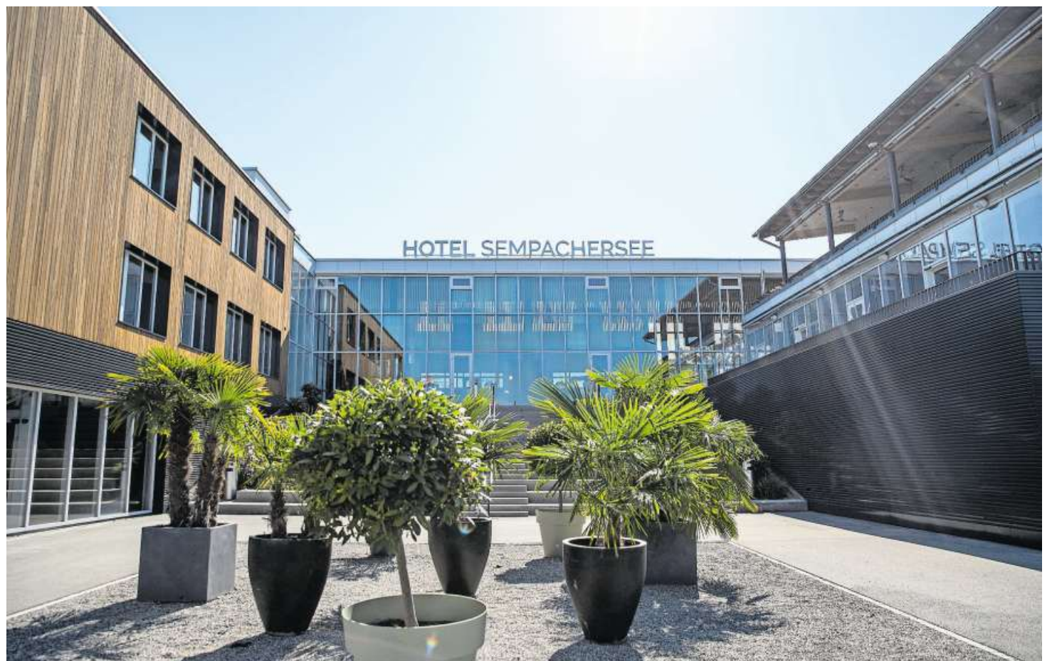
Das Hotel Sempachersee trägt zur Zunahme an Logiernächten in der Region bei.
