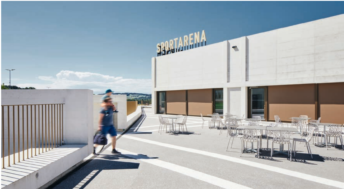
Die Sportarena auf dem Campus Sursee: weisser Beton als Reverenz ans klassische Baumeisterhandwerk.
