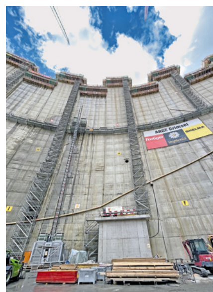
Täglich werden für den Bau der Staumauer 500 m 3 Beton benötigt und vor Ort hergestellt.
