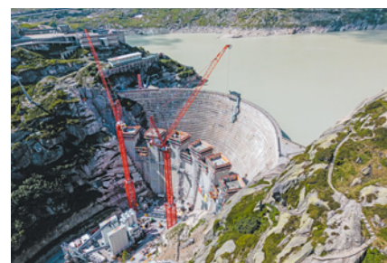
Rund 100 Menschen arbeiten im Schichtbetrieb an der Staumauer.
